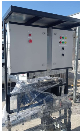
Img. 2: Tableros de fuerza y control.
